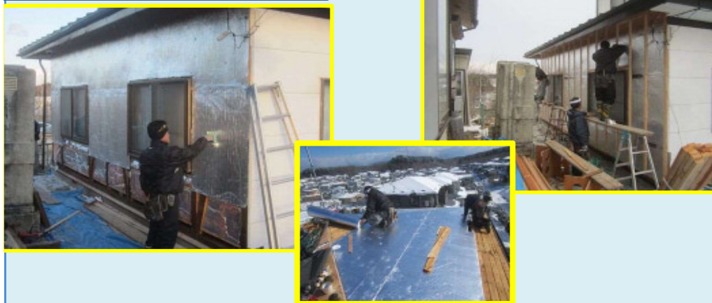
M様邸リフォーム工事(八戸市)
